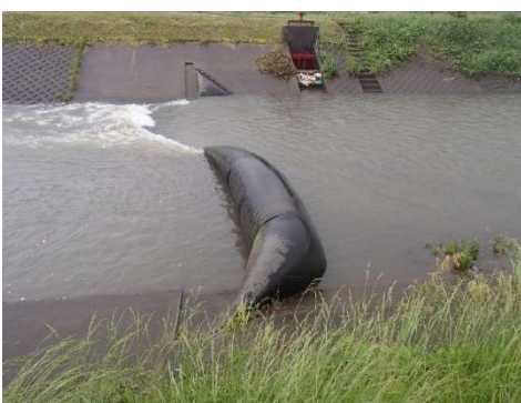
ゴム堰袋体（左岸側が完全倒伏不可）
