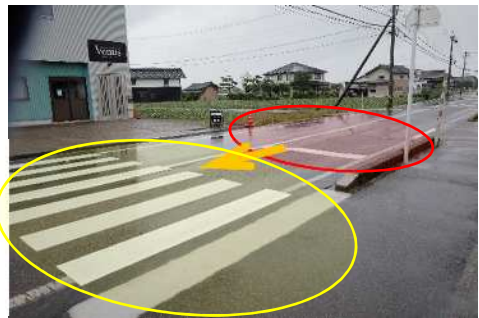
③対策後 移動された横断歩道
