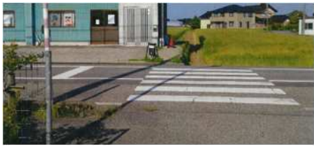
①対策前の事故現場（突き当りに用水）
